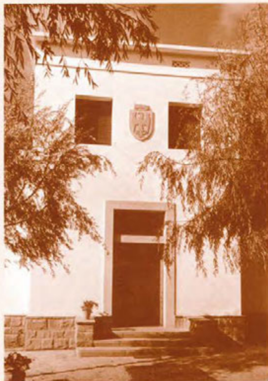
L'entrada a l'hospital s'ha mantingut igual des de l'edifici de 1940. Fixem-nos que al principi només tenia un pis
